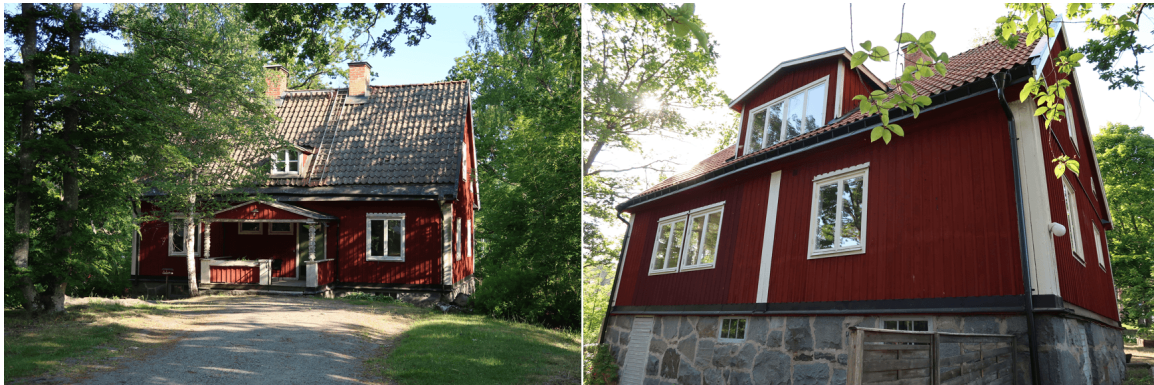
Figur 7: Till vänster rektorsvillans framsida med öppna verandan med profilerade pelare samt den lilla takkupan. Till höger baksidan med hög grund av tuktad fogad natursten och källardörr. Bildkälla: Nacka kommun.
